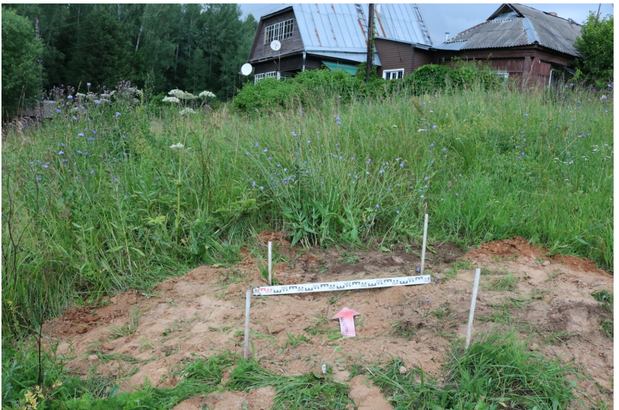
Рис. 30. Археологическое обследование участка по объекту: «Уличные газопроводы дер.Воронки Износковского района Калужской области». 2023 г. Шурф №2. Рекультивация. Вид с Ю.
